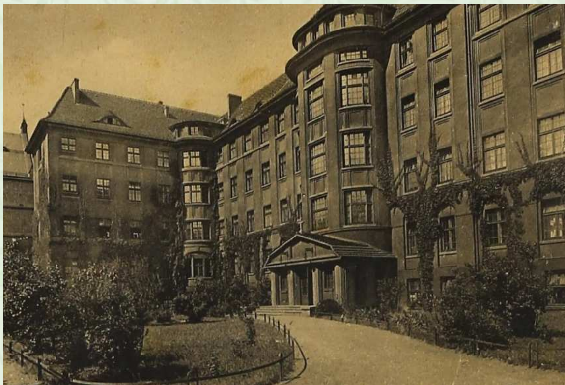
A bresloui kórház épülete
